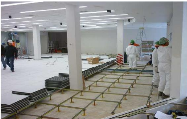
Figura 7: Piso técnico elevado
